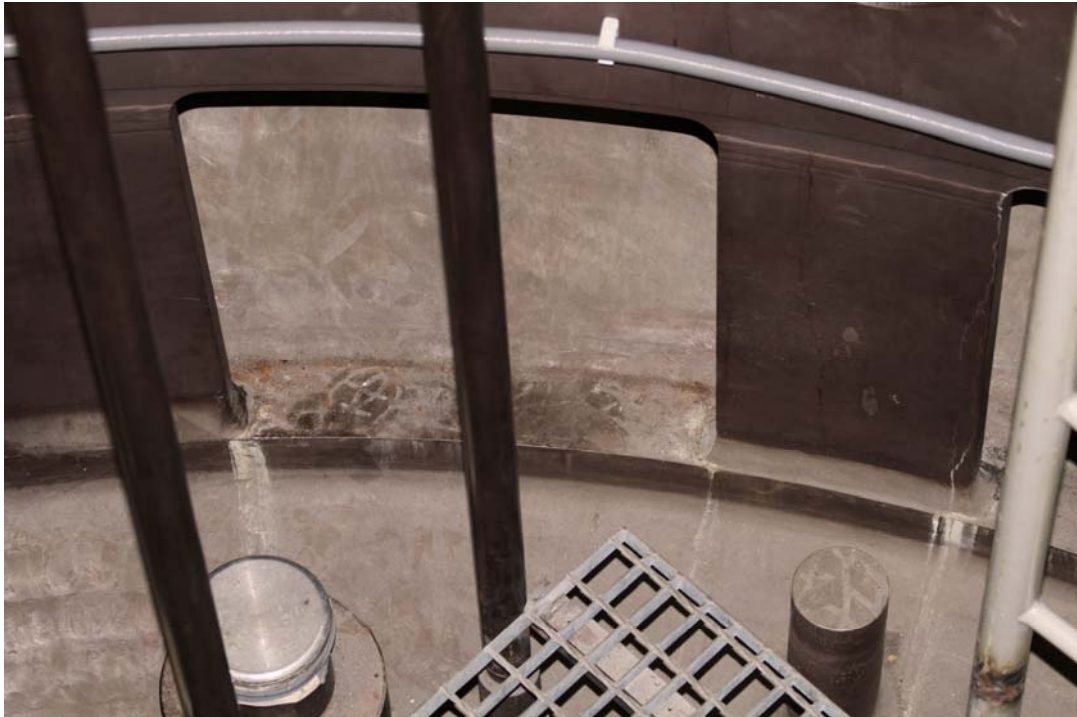
Abbildung 5: Ansicht des unteren Randes des Kernmantels auf der Bodenkalotte des Reaktordruckbehälters (RDB) des KKW Zwentendorfs aufsitzend und fest mit der Bodenkalotte verschweißt. Der Kernmantel kann für Prüfzwecke nicht aus dem RDB entfernt werden – die Prüfbarkeit beispielsweise auf entstandene Haarrisse mit zerstörungsfreien Prüfverfahren des nach einer einiger Betriebsdauer strahlenden Reaktordruckbehälters im Bereich der Bodenrundsweißnaht ist nicht gegeben (Photo: Richard Kromp).
